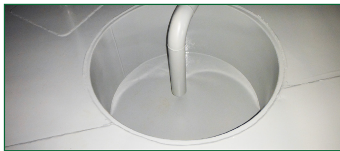
Revestimiento Novocoat SP2000AR Ceramic Coating en un registro de tanque
