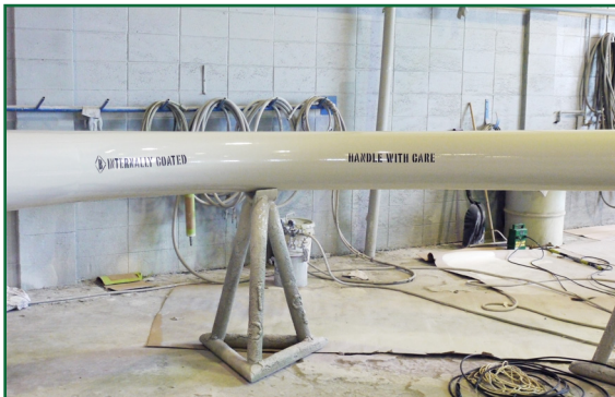
Novocoat SC2200 Rapid Set Pipe Coating aplicado en el exterior. Novocoat SC3300 Novolac Epoxy Lining aplicada en el interior.
